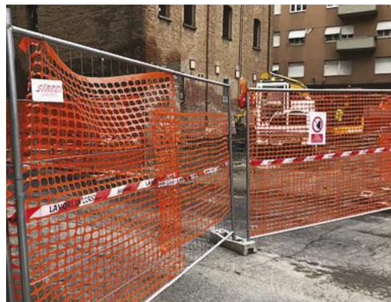
↑ Una parte del cantiere di via Riva Reno
